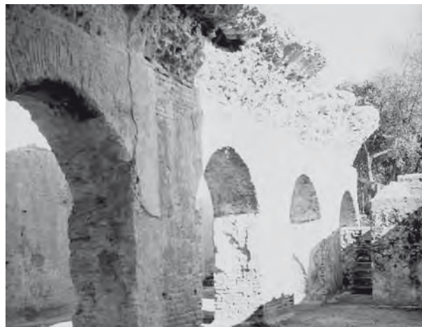
La cisterna prima degli interventi di restauro
