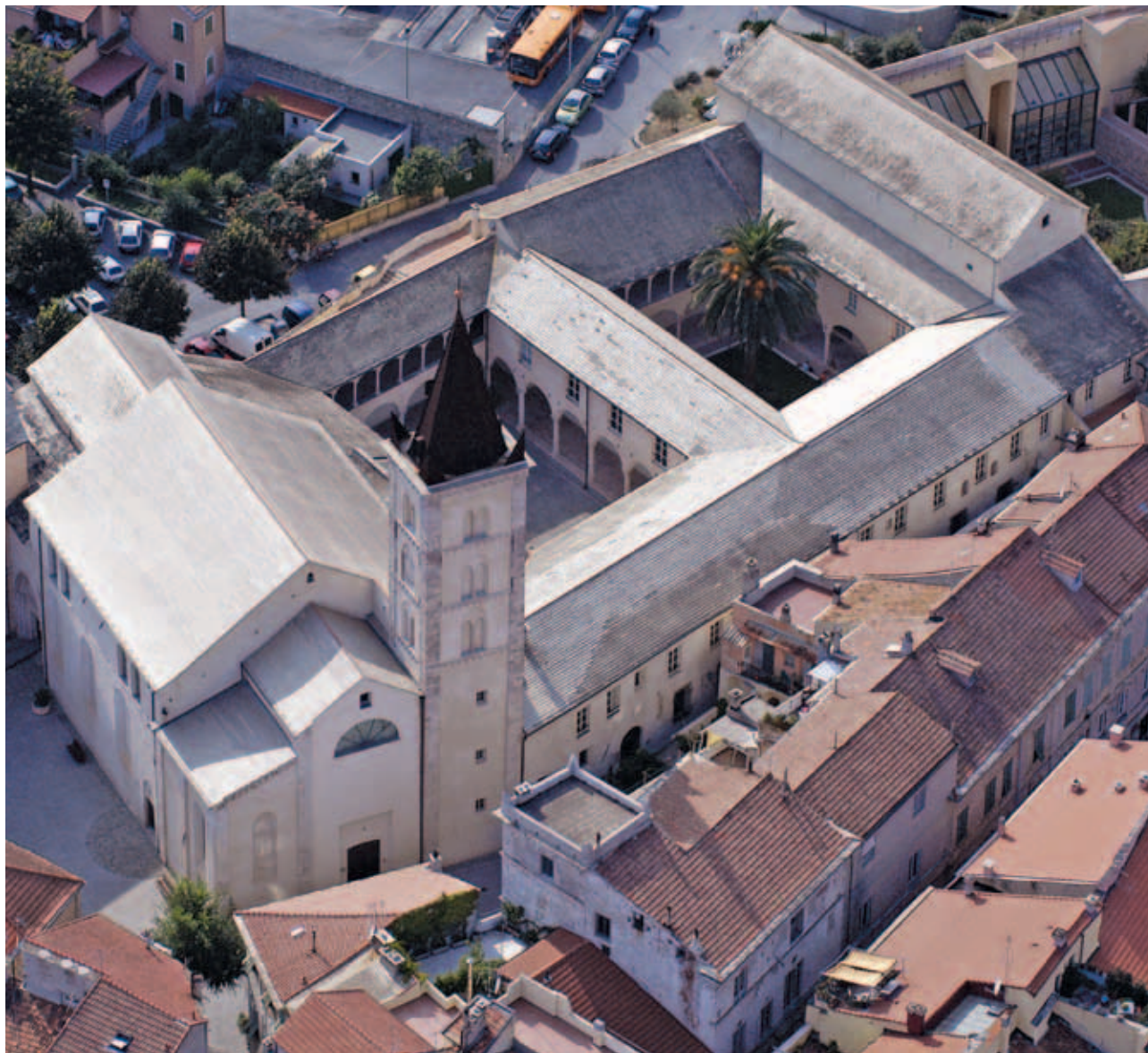
Veduta aerea del complesso conventuale di Santa Caterina in Finalborgo con i due chiostrini rinascimentali, sede del Museo Archeologico del Finale
