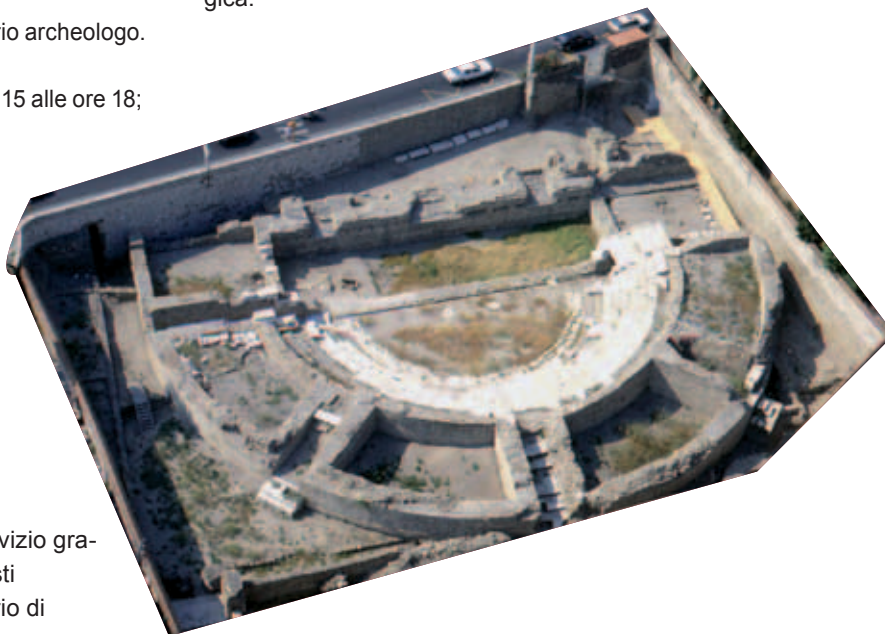
Veduta aerea del teatro
